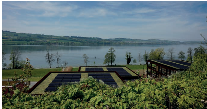
Abb. 11 Visualisierung der Überbauung Seefeld ab dem Feldweg (Quelle: Leuenberger Architekten AG)
