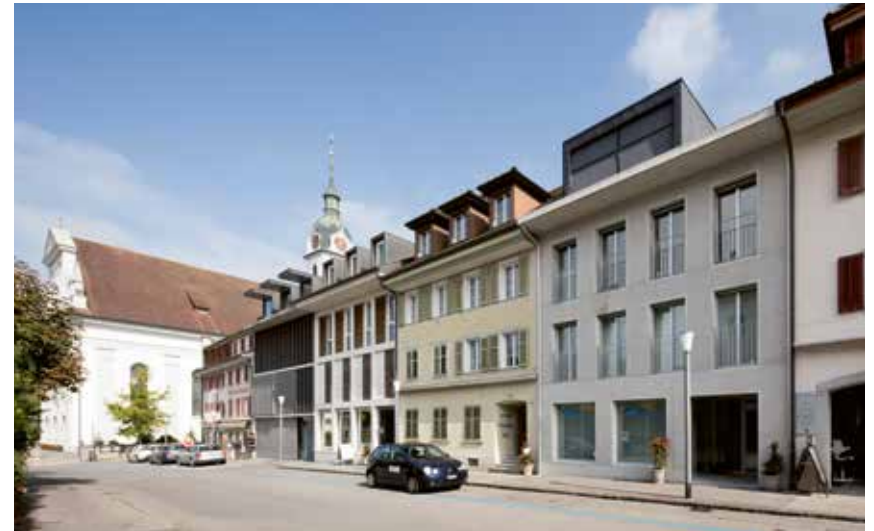
Altstadt: Drei Neubauten an der Oberstadtstrasse (2000, 2004 und 2011). — Vieille ville: trois nouveaux bâtiments sur la rue Oberstadt (2000, 2004 et 2011).
