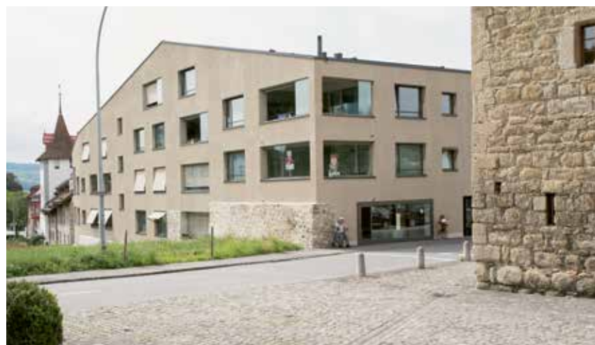
Der Stadteingang ist eine Visitenkarte: Südöstliche Ansicht der Gewerbe- und Wohnüberbauung Mühle mit Stadtgraben links im Bild (2009–2015). — L'entrée de la ville est une vitrine: vue du complexe mixte Mühle (2009–2015) depuis le sud-est avec, sur la gauche, l'ancien fossé de la ville.
