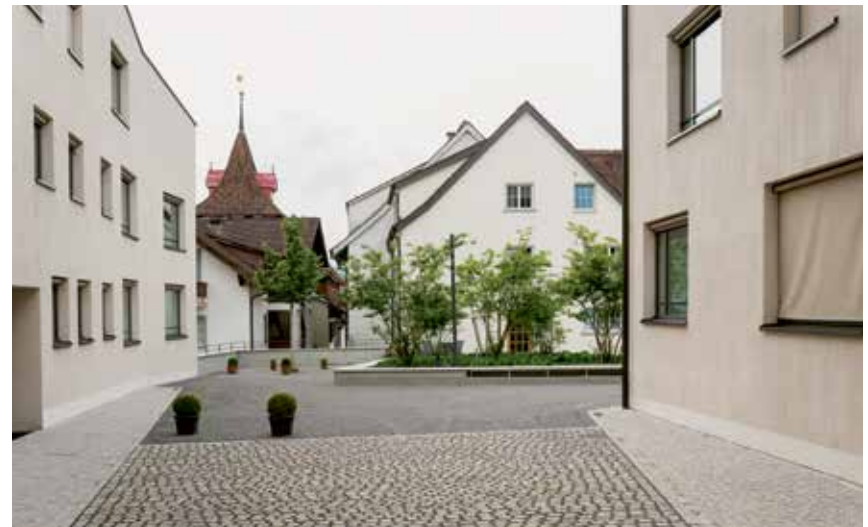
Aufgewerteter südöstlicher Eingang zur Altstadt: Der halböffentliche Innenhof der Gewerbe- und Wohnüberbauung Mühle (2009-2015). — Requalification de l'entrée sud-est de la vieille ville: la cour intérieure semi-publique du complexe d'habitation et d'activités Mühle (2009-2015).
