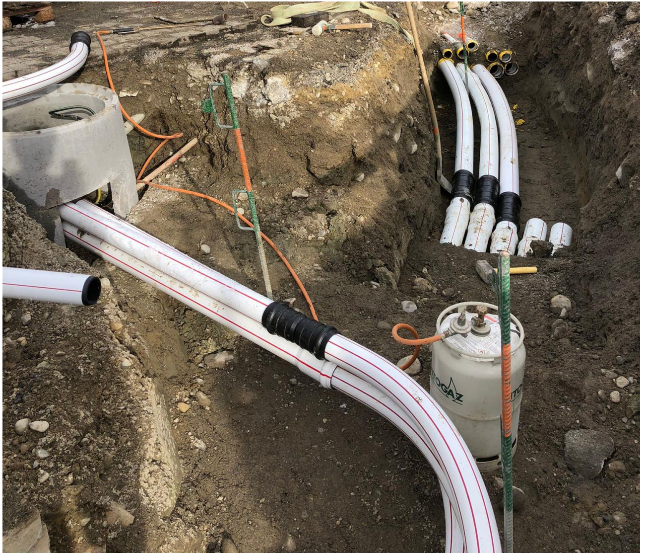
Blick in die Baugrube
