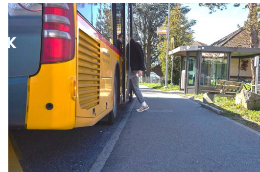
Bushaltestellen nicht hindernisfrei
